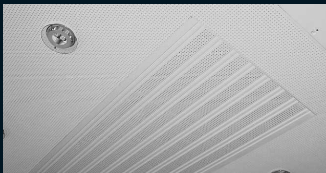
Comme chauffage de couloir avec intégration dans un plafond fermé en exécution perforée – centre des expositions à Graz
