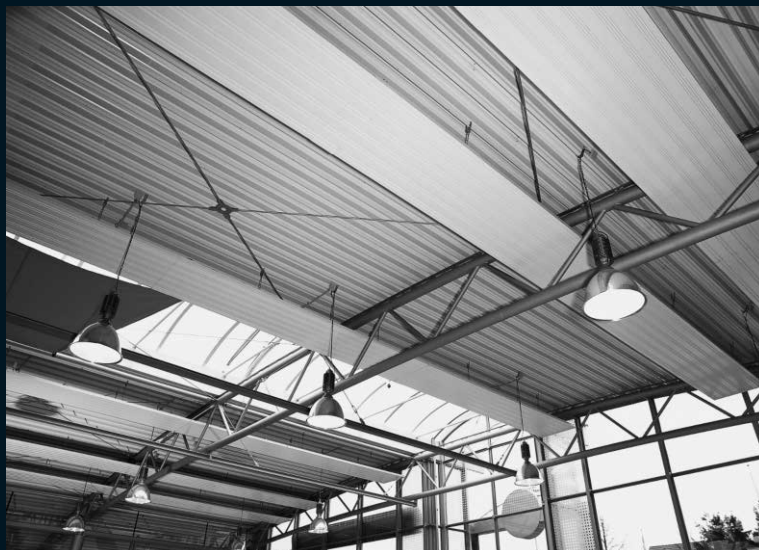
Plafonds rayonnants SUNLINE disposés en harmonie avec le plafond du bâtiment et faits de supports à rayonnements dans un garage automobile à Kassel .
