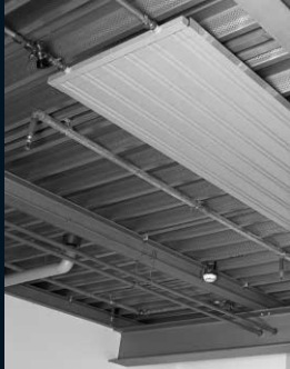
Plafonds rayonnants SUNLINE disposés en harmonie avec le plafond du bâtiment et faits de supports à rayonnements dans un garage automobile à Kassel .
